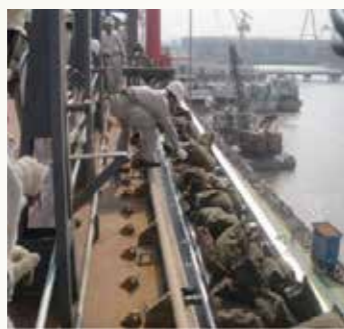
传统的压重工艺，存在安全风险
