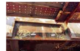
双向定位销分段划线做好样冲点保护
