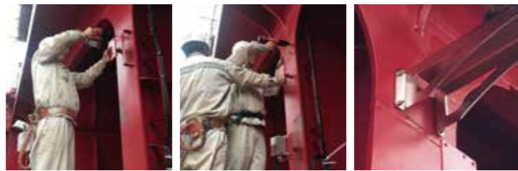
1. 钢结构预钻孔
