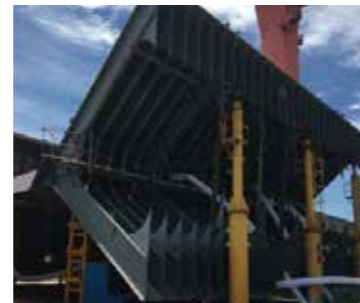
槽型舱壁小甲板总组
